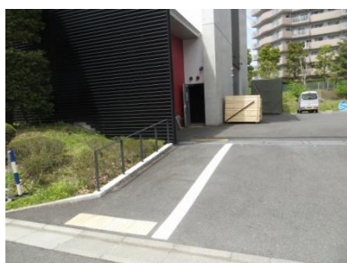
撮影スタジオ障害者用通路
