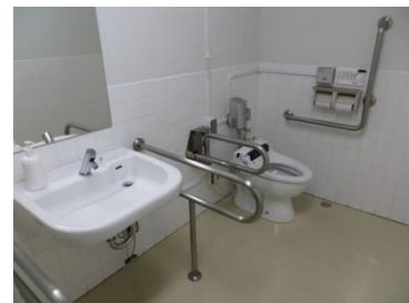
多目的トイレ内部
