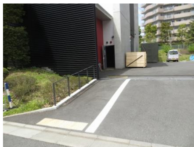
撮影スタジオ障害者用通路
