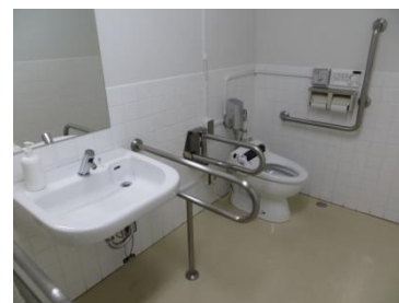
多目的トイレ内部
